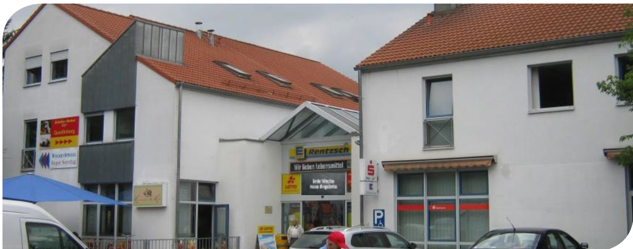
Ansicht auf die Westseite des Gebäudes
