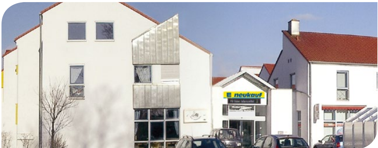
Westseite des Gebäudes
