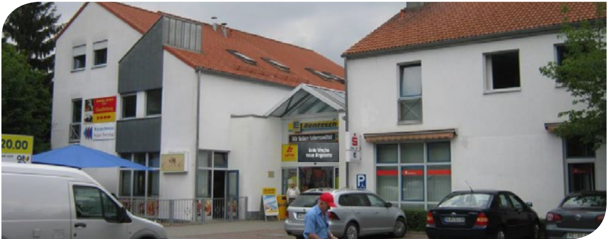
Westseite des Gebäudes
