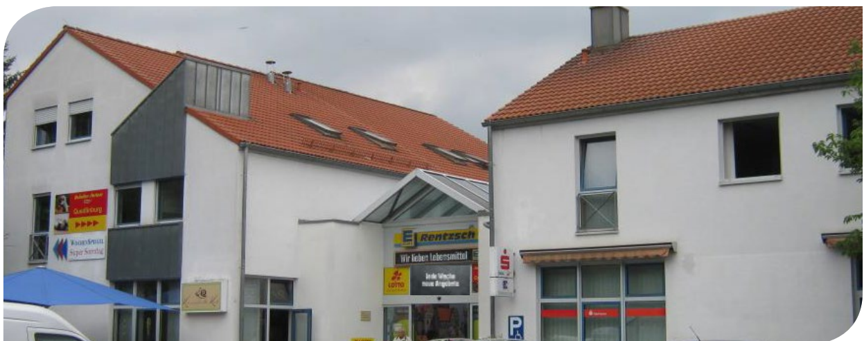
Westseite des Gebäudes
