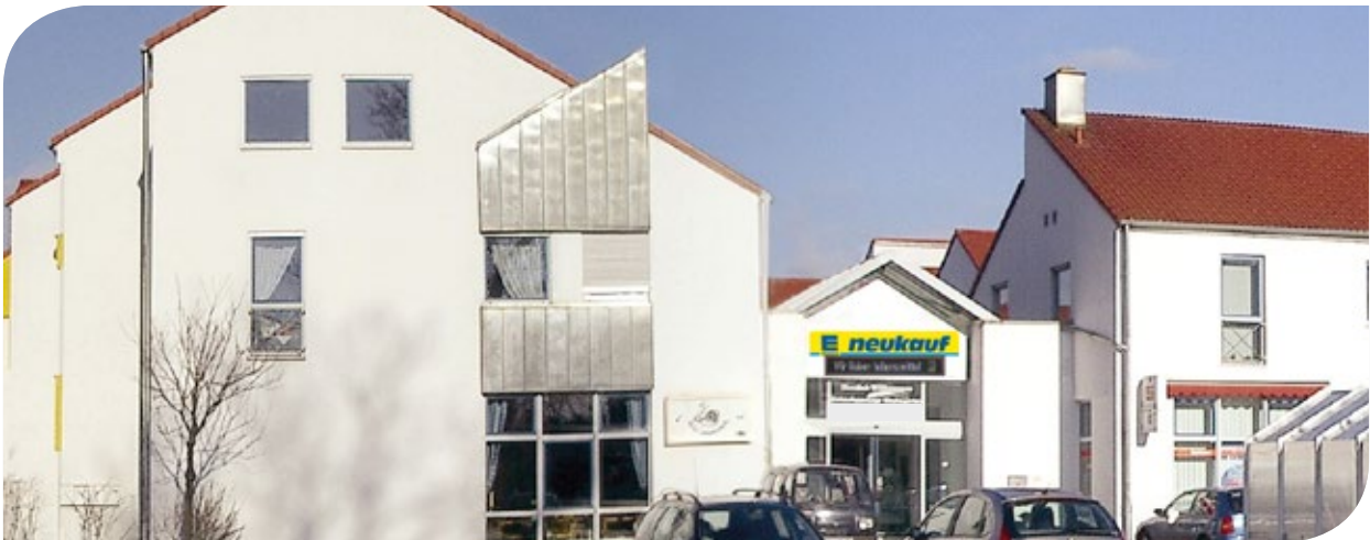
Westseite der Immobilie
