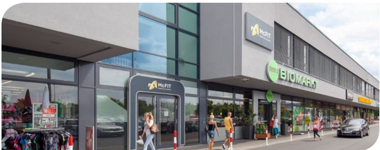
Eingang in das Fitnessstudio McFit im Obergeschoss des Erweiterungsbaus
