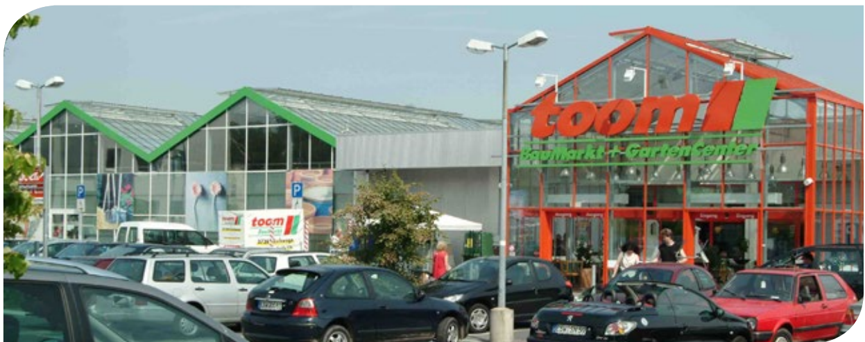
Blick auf das Baumarkt-Gebäude mit Haupteingang zum Mieter toom
