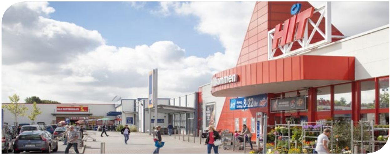
Fachmarktzentrum Georg Park Euskirchen mit Gebäudeteil HIT
