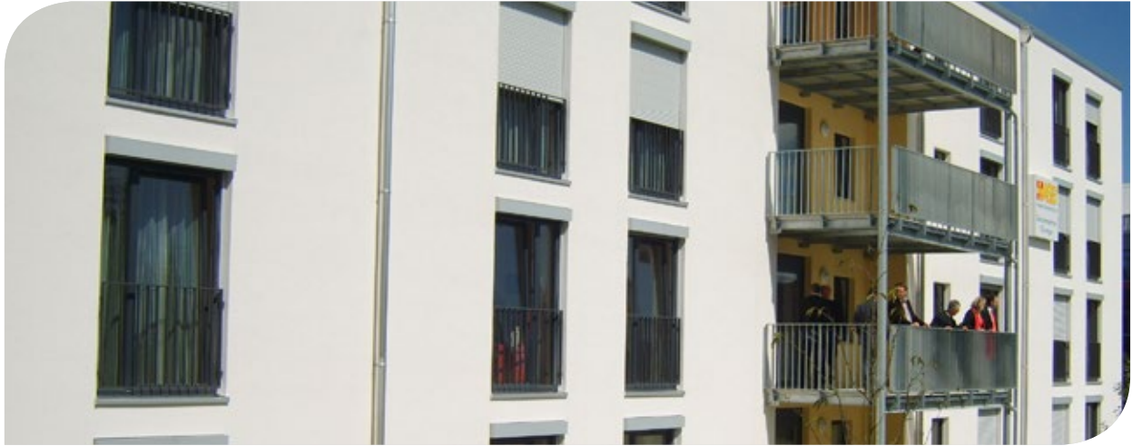
Südostansicht des Gebäudeensembles
