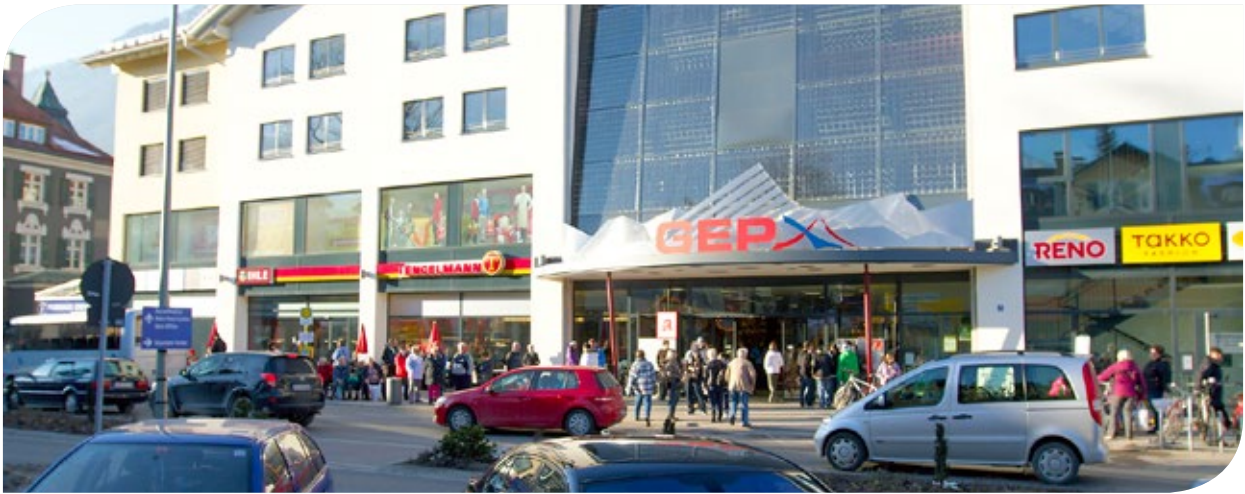
Haupteingang Fondsimmoblie GEP in Garmisch-Partenkirchen
