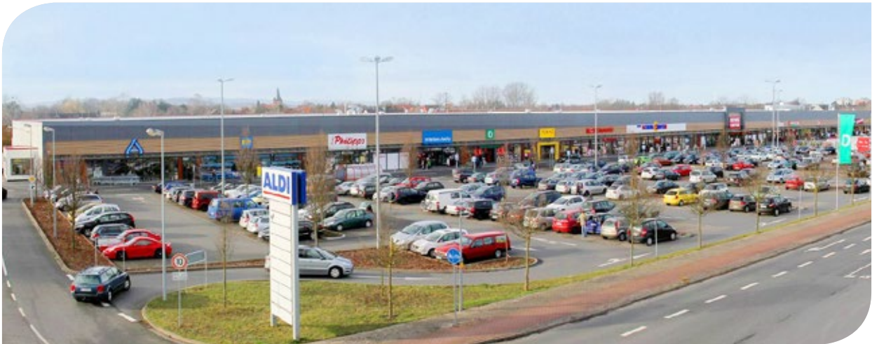
Ansicht auf das Calenberg Center in Pattensen
