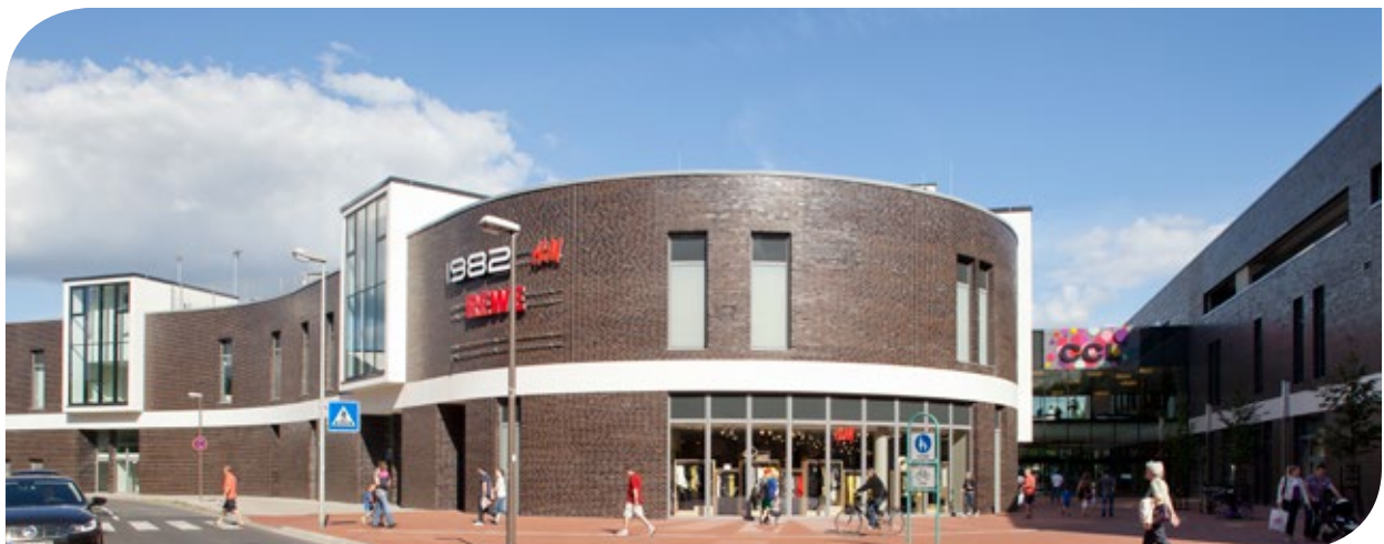
Eingang in das CCL (Eingang Schützenstraße)
