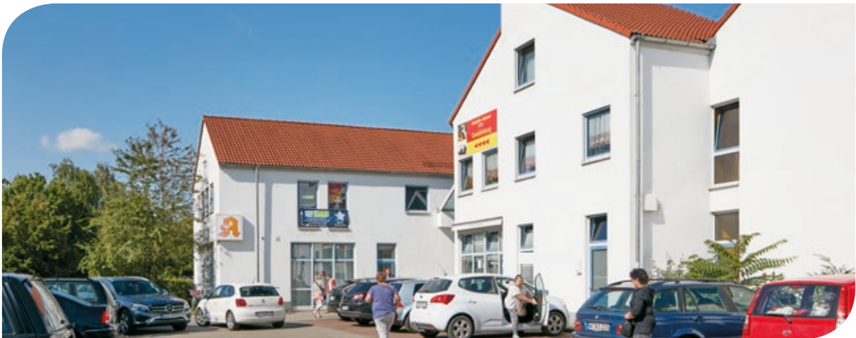
Westseite der Fondsimmobilie
