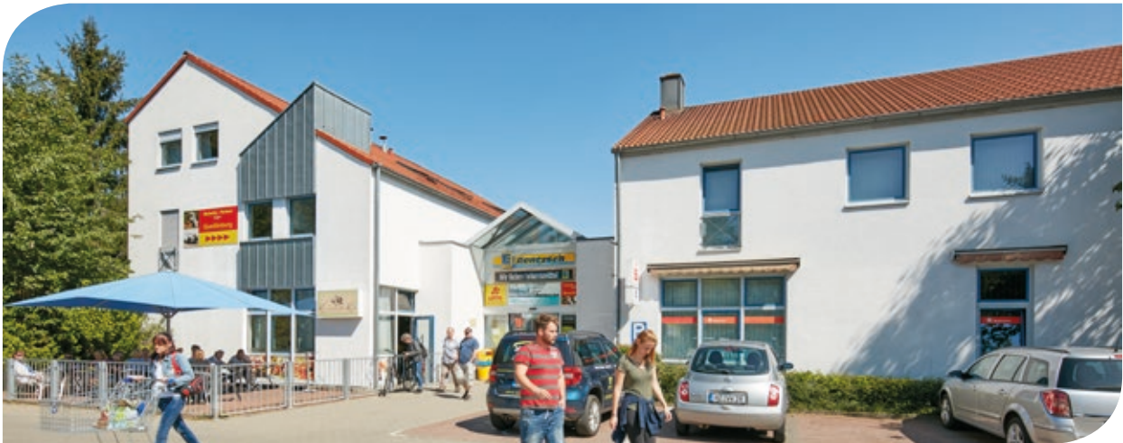
Westseite des Gebäudes
