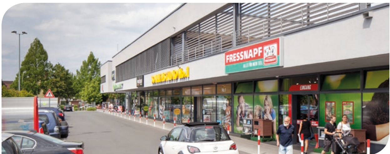
Eingangsbereich der Handelsmieter
