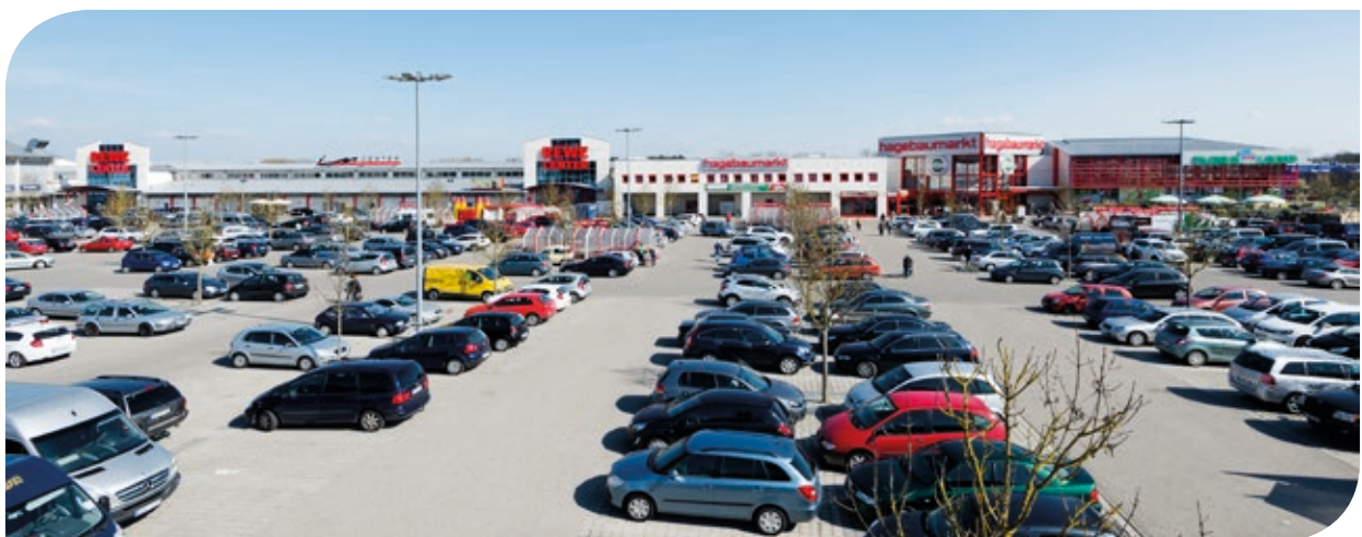
Parkplatz vor dem Hauptgebäude
