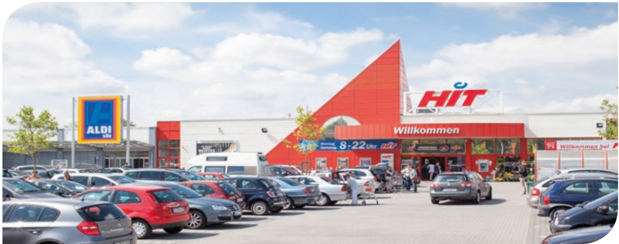
Fachmarktzentrum Georg Park Euskirchen mit Gebäudeteil HIT und ALDI
