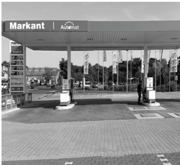
Neu errichtete Tankstelle im Georg Park unter dem Labelnamen "Markant"
