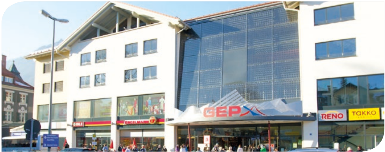
Einkaufszentrum GEP in Garmisch-Partenkirchen
