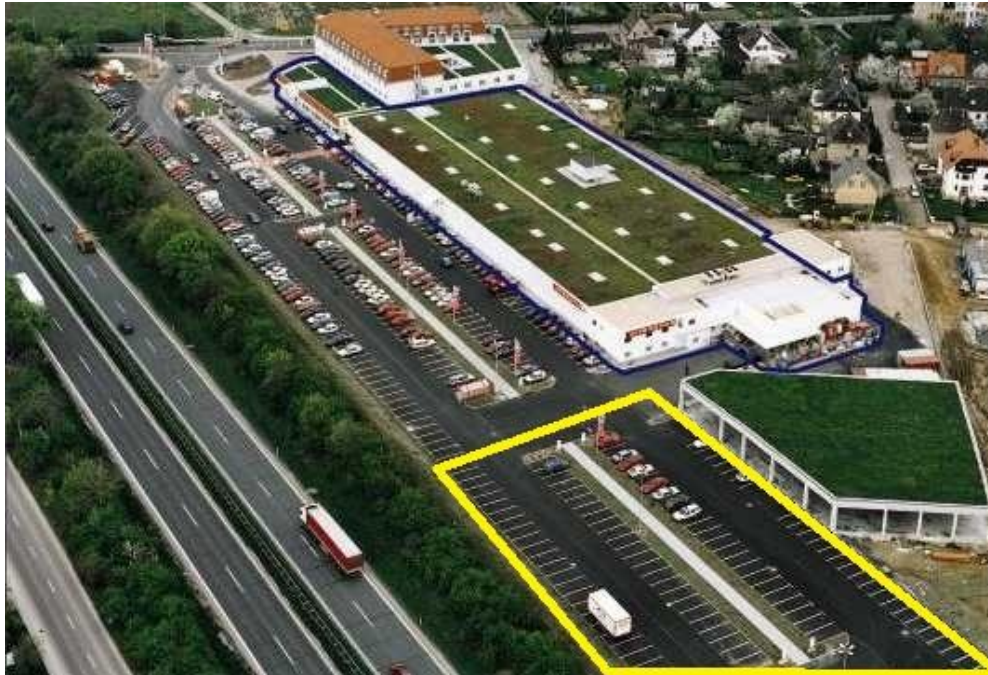
Luftbild der gesamten Parkplatzanlage (vor Umbau) mit heller Markierung des Nachbarparkplatzes im Vordergrund
