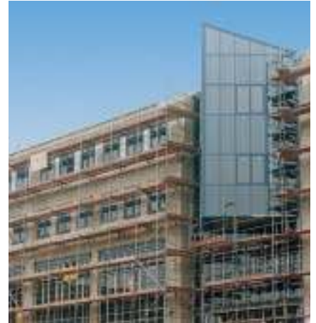
Teilansicht Hauptgebäude. Baustellenfoto vom 28.11.1995
