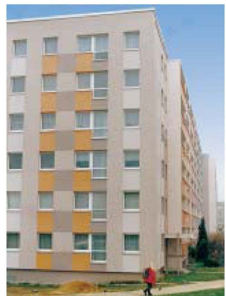
Modernisierte Wohnhäuser in Gorbitz
