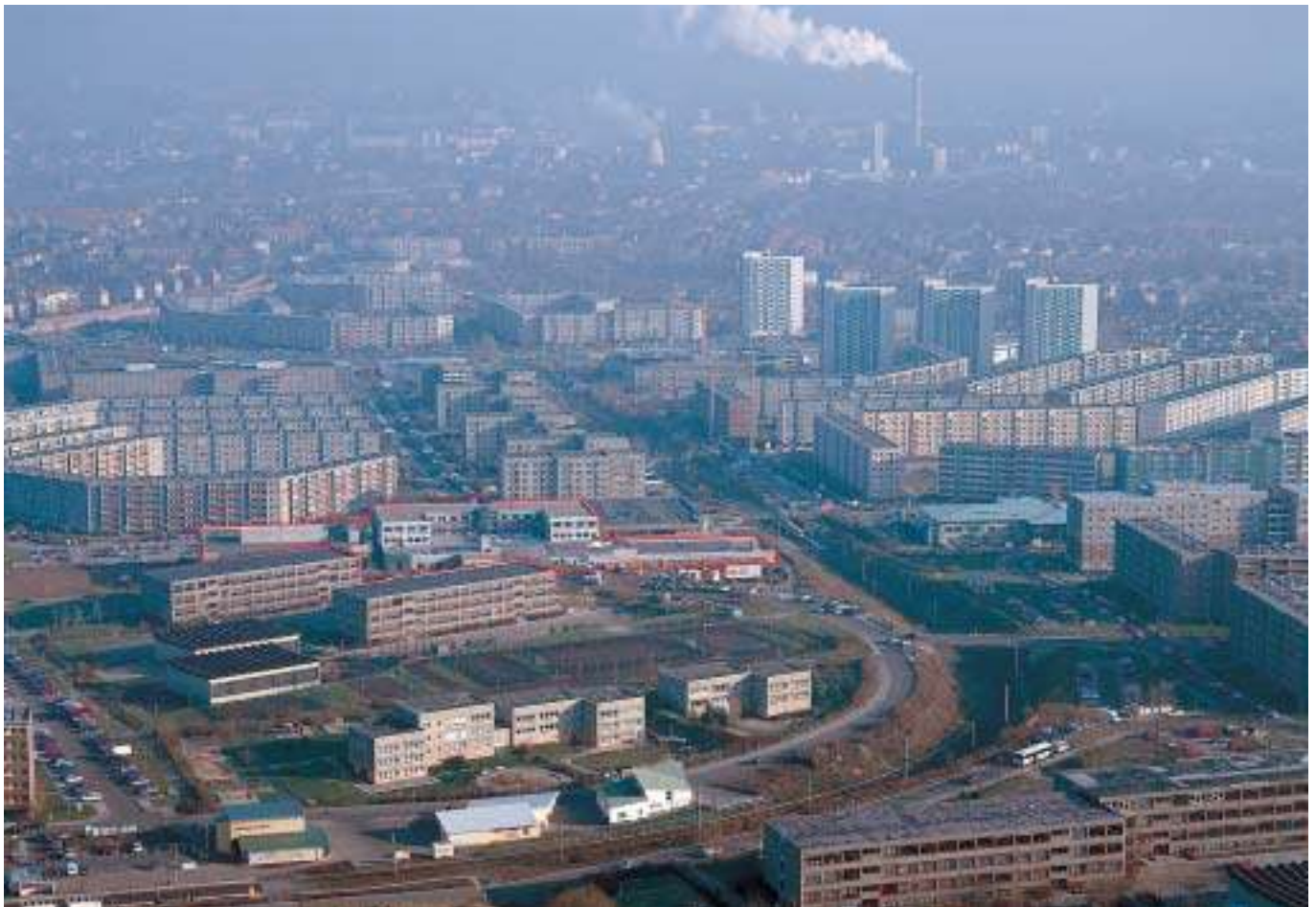
Teilansicht Stadtteil Dresden-Gorbitz, das Stadtteilzentrum „Sachsen-Forum“ ist rot gekennzeichnet, in der Mitte des Luftbildes (südlich des Standortes) die tiefergelegte Straßenbahntrasse. Das Luftbild dokumentiert die Lage des Stadtteilzentrums als räumlichen Mittelpunkt von Dresden-Gorbitz. Im Hintergrund die Innenstadt von Dresden.
