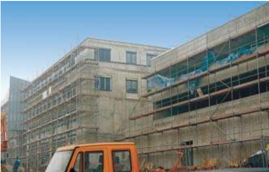
Teilansicht Stadtteilzentrum „Sachsen-Forum“. Baustellenfoto vom 28.11.1995
