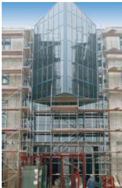
Eingangsbereich „Sachsen-Forum“, Baustellenfoto vom 28.11.1995
