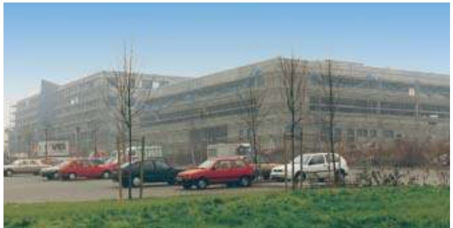
Teilansicht der Fonds-Immobilie, Baustellenfoto vom 28.11.1995, links im Bild der zentrale Gebäudeteil, rechts das dreigeschossige Parkhaus. Es überbaut teilweise die Fläche des Konsum Verbrauchermarktes in der Ebene 0.
