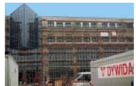
Teilansicht Haupteingang der Fonds-Immobilie. Rechts im Bild ein Container des Großbauunternehmens DYWIDAG, das die Arbeitsgemeinschaft für die Baudurchführung führt. Baustellenfoto vom 28.11.1995.
