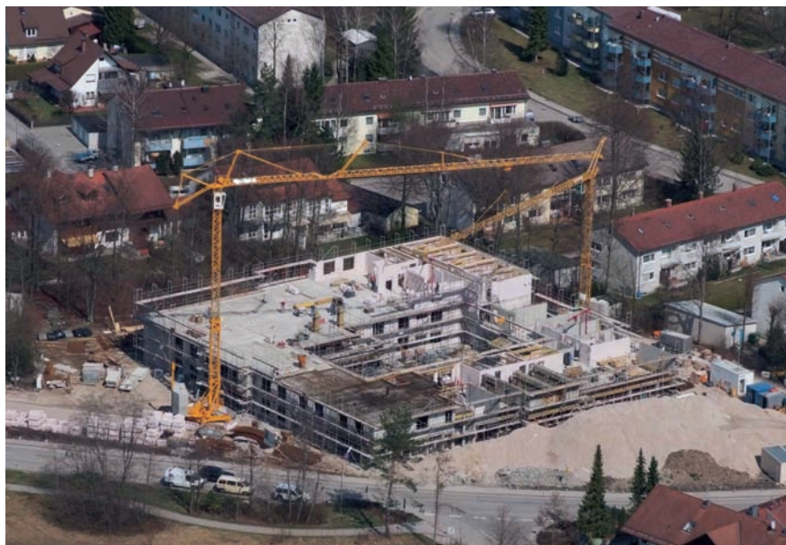
Luftansicht der Baustelle des Pflegeheims Geretsried – Stand 14.04.2009
