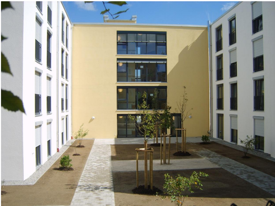
Ansicht Innenhof - Süden
