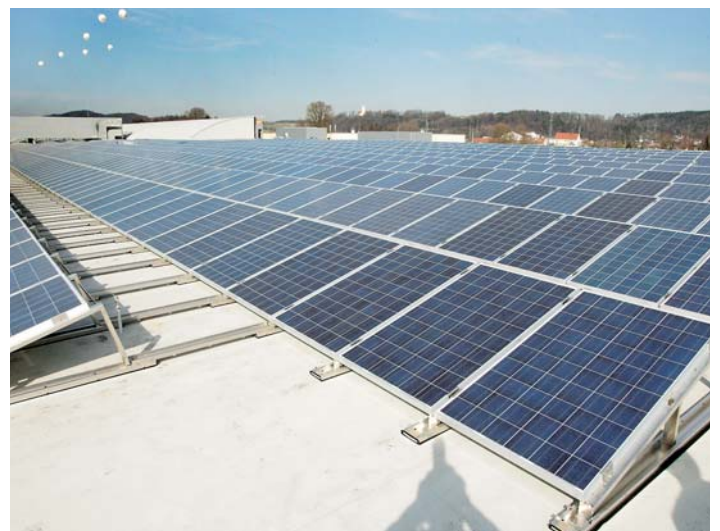
Dach des Landshut Park mit Photovoltaikanlage
