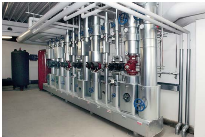
Haustechnische Anlagen im Landshut Park
