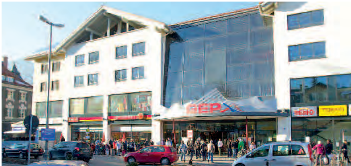
Außenansicht „GEP“, Straßenfront Von-Brug-Straße
