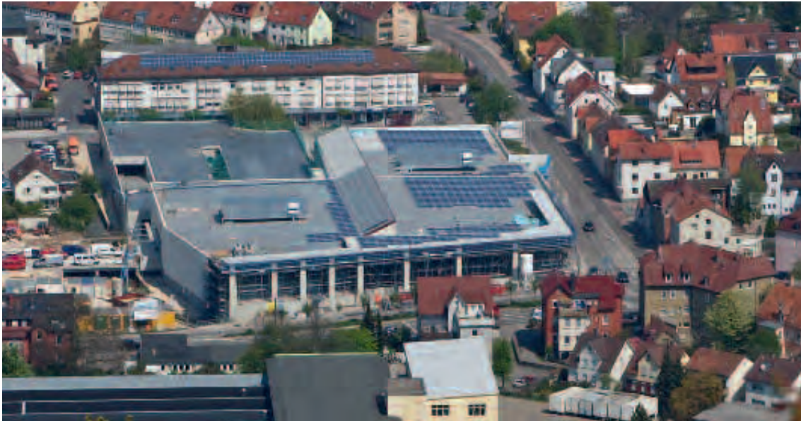
„Nel Mezzo“ Geislingen, Baustand im April 2011
