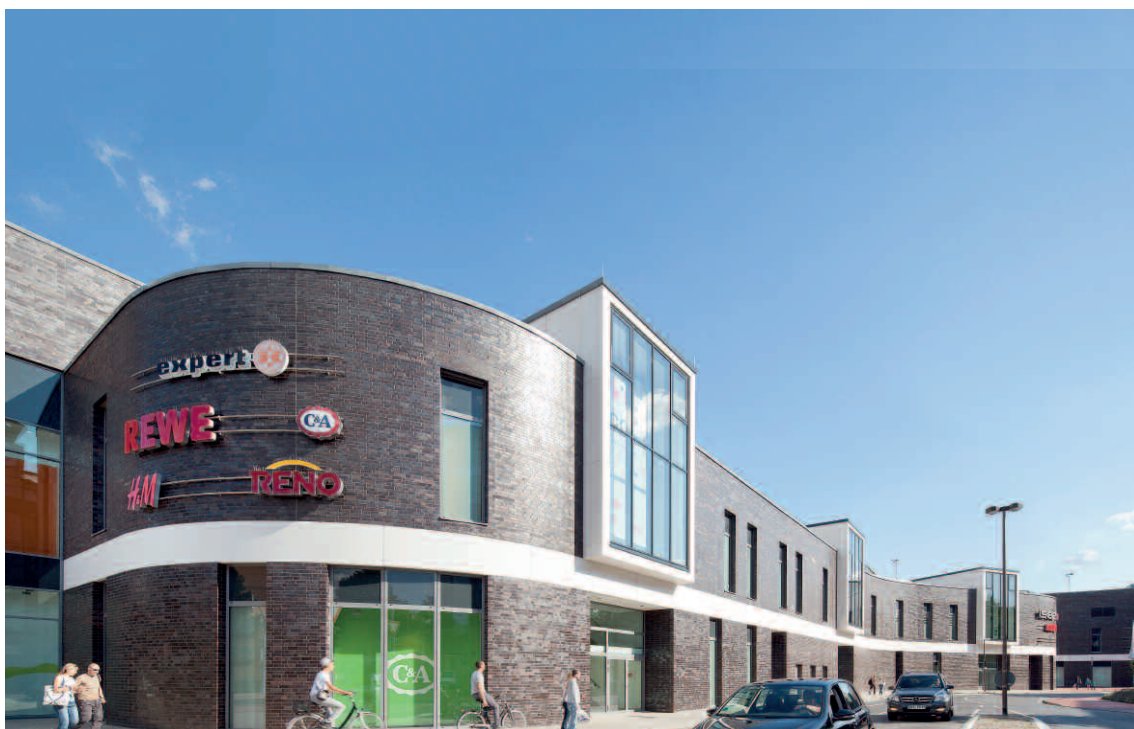
CCL Neubau – Ansicht Schützenstraße
