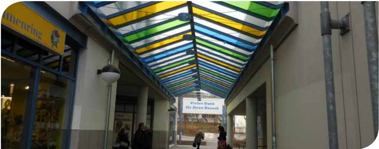
Glasdach mit neuem Farbkonzept
