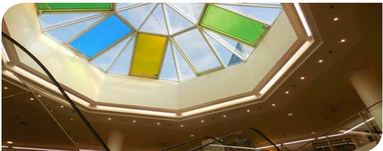
Lichtkuppel in der Mall nach Modernisierung
