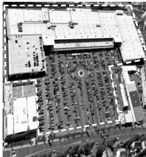
RING CENTER, Offenbach, Bestandsbau
