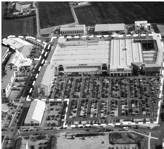
InCenter, Dachau (Bauteil I rechts, Bauteil II links Umrandung)
