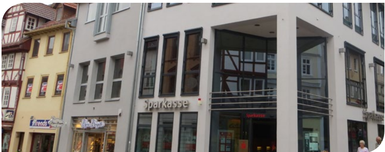
Eingang zur Sparkasse von der Fußgängerzone Ecke Stad/Herrengasse
