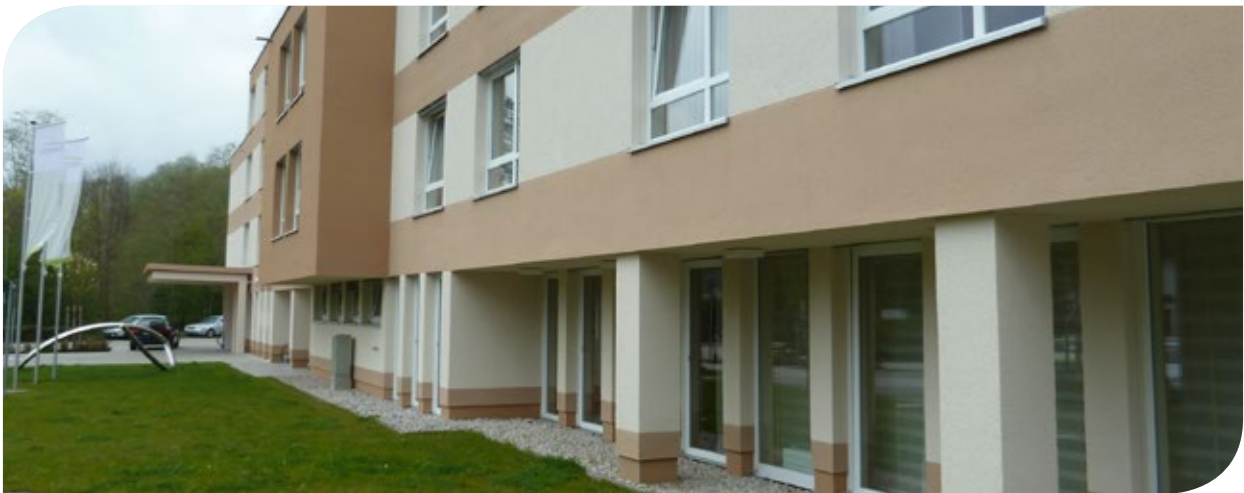
Haupteingang mit Blick auf die Frontseite des Gebäudes
