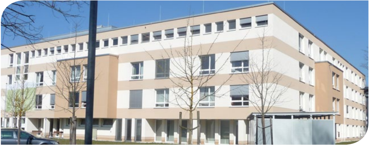
Ansicht auf das Gebäudeensemble vom Besucherparkplatz
