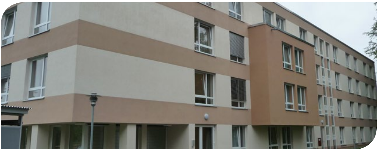
Blick auf die Ostseite der Fondsimmoblie
