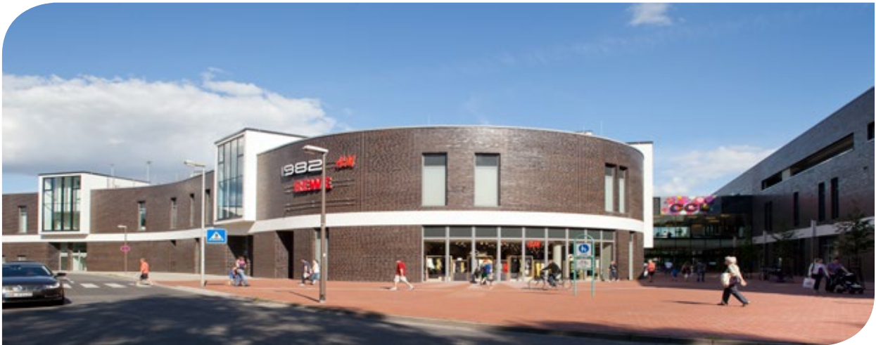
Eingang in das CCL (Eingang Schützenstraße)
