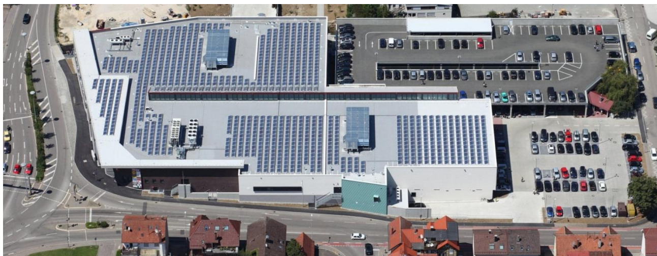
Das fertiggestellte Einkaufszentrum Nel Mezzo in Geislingen
