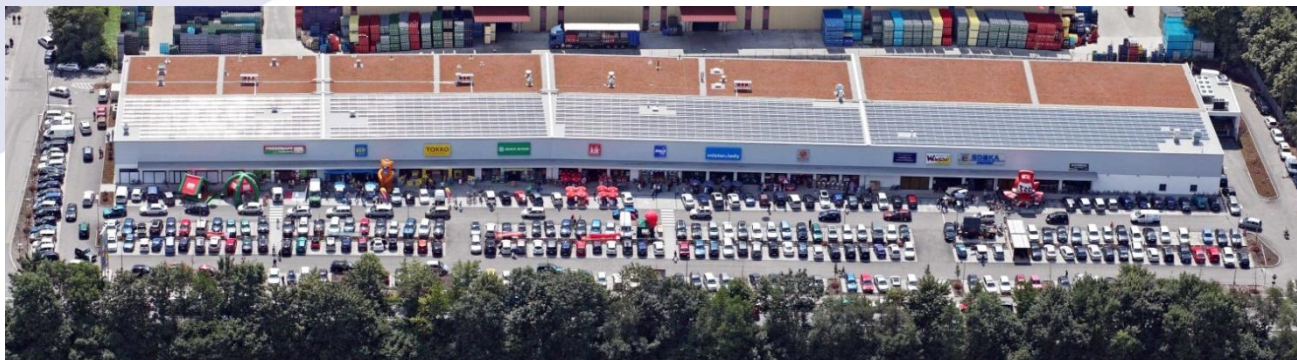
Das fertiggestellte Fachmarktzentrum in Unterschleißheim
