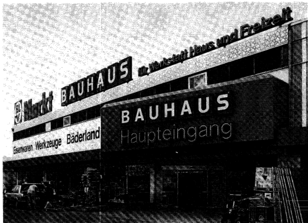
EKZ-Haupteingang des Mieters Bauhaus
