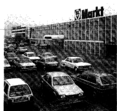
Einkaufszentrum mit Haupteingang, BLV und Bauhaus sowie Parkfläche
