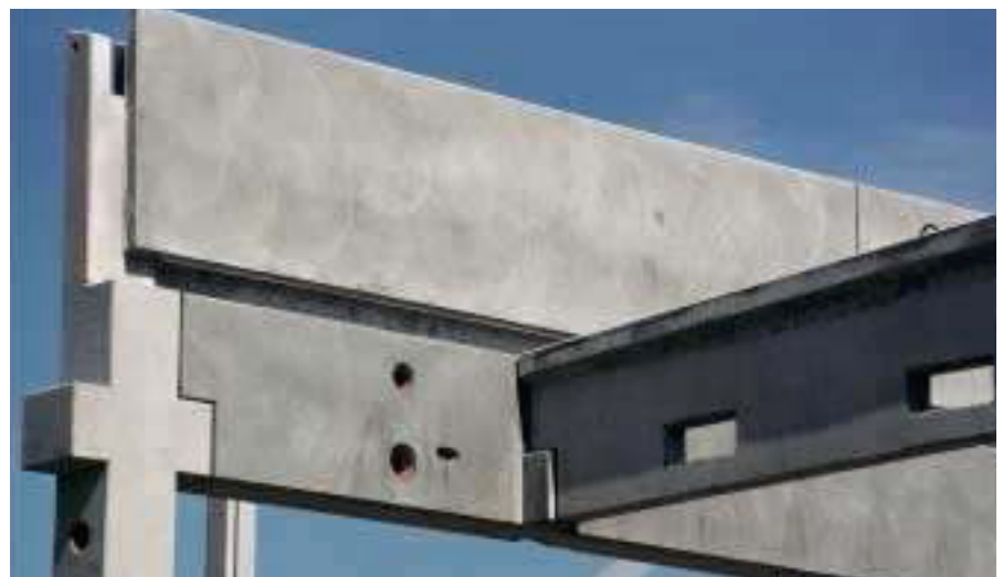
Fotoserie „Kunst am Bau“ : Fertigteilkonstruktion, Aufnahmedatum 05.06.2000
